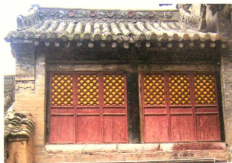
图 1-4 辽、宋、金、元木装修：双腰串（四抹隔扇）
