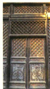
图 1-4 辽、宋、金、元木装修：双腰串（四抹隔扇）
