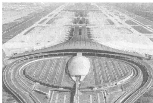
图 1-11 机场工程——首都国际机场3号航站楼
