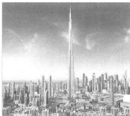
图 1-1 建筑工程——阿联酋迪拜布吉大楼
