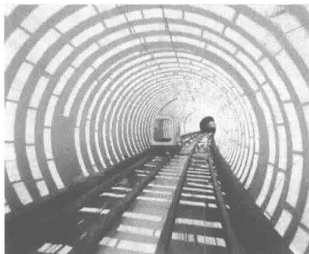
图 1-8 隧道与地下工程——我国首条越江行人隧道(黄浦江行人隧道)
