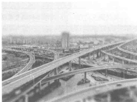
图 1-4 公路与城市道路 工程——南京双桥门立交
