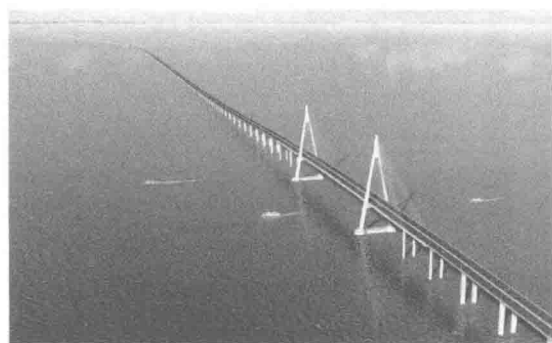
图 1-6 桥梁工程——杭州湾跨海大桥
