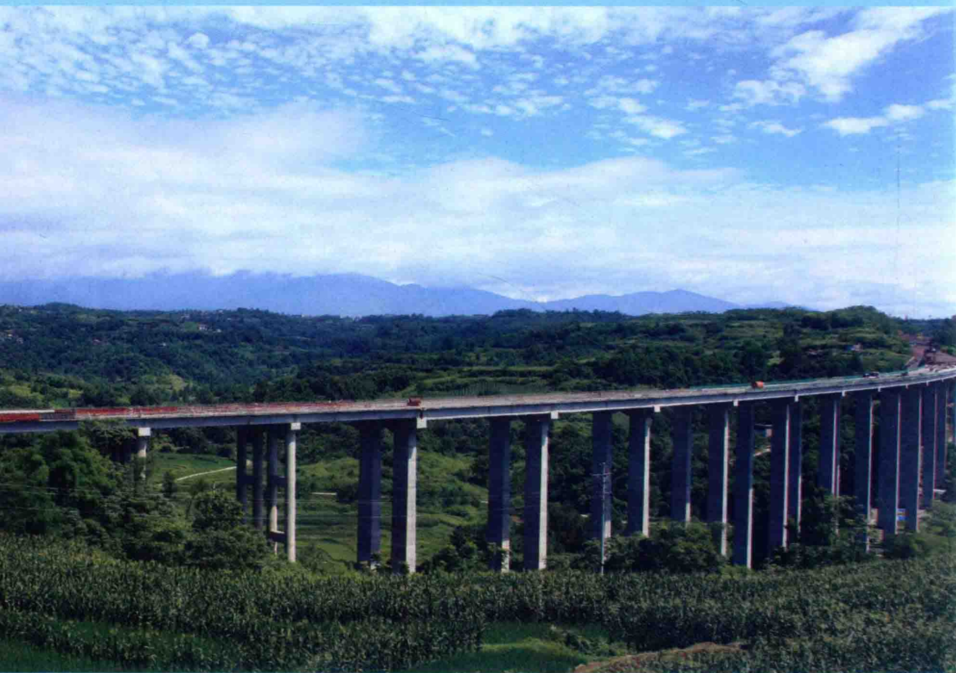
渝广高速流溪河大桥
