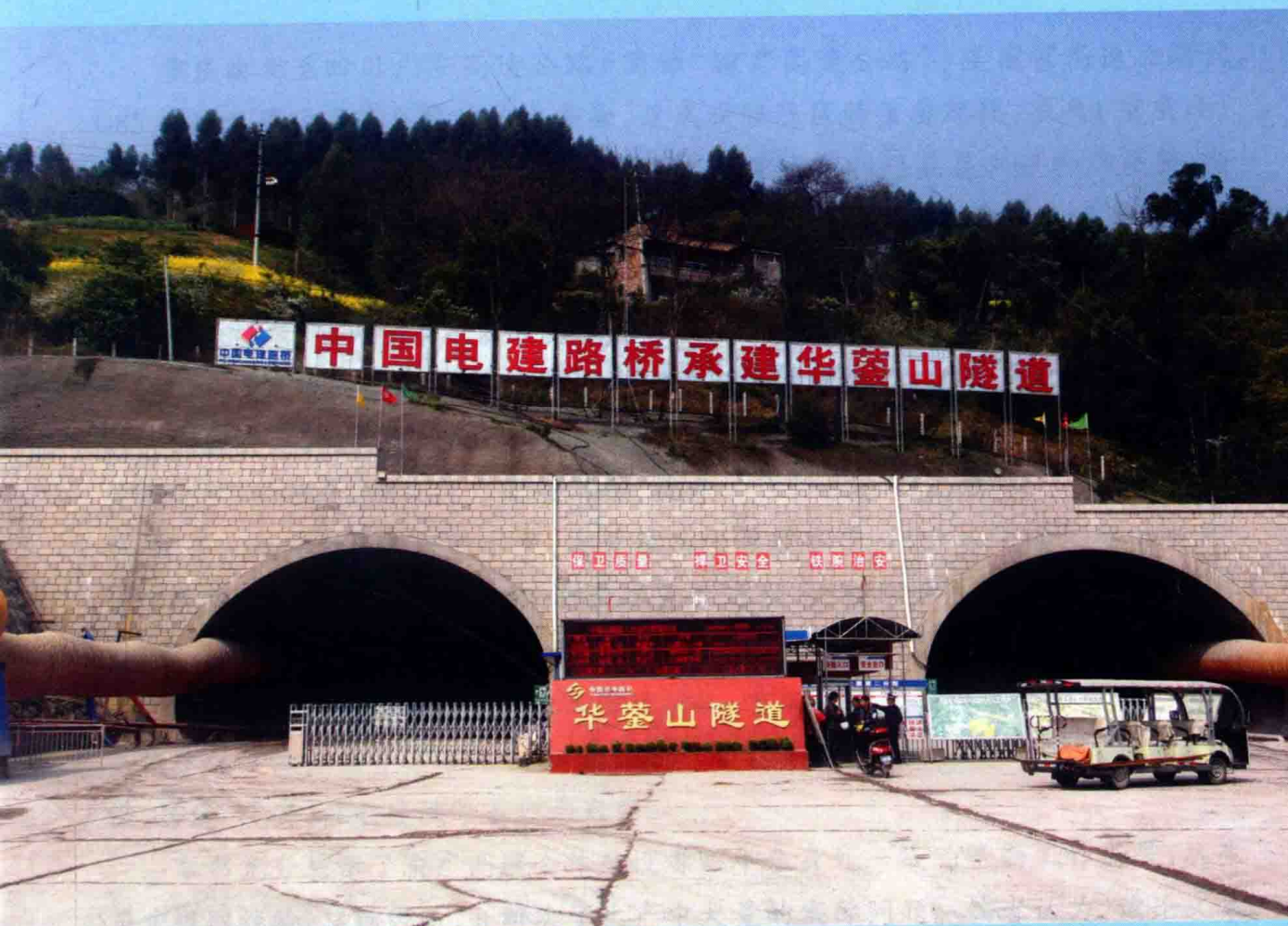
渝广高速华蓥山隧道进口
