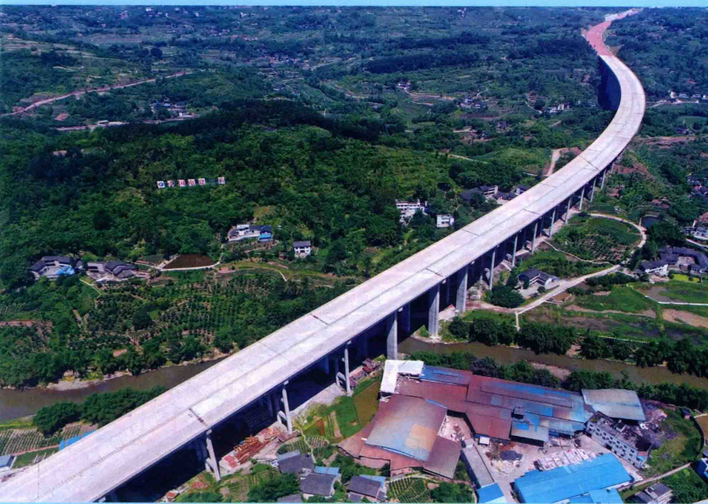
渝广高速黑水滩河特大桥
