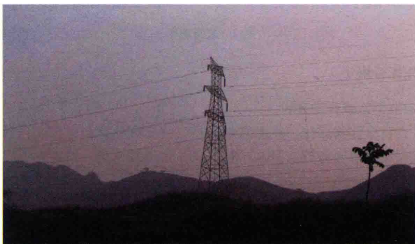
图 3 故障杆塔现场环境情况
