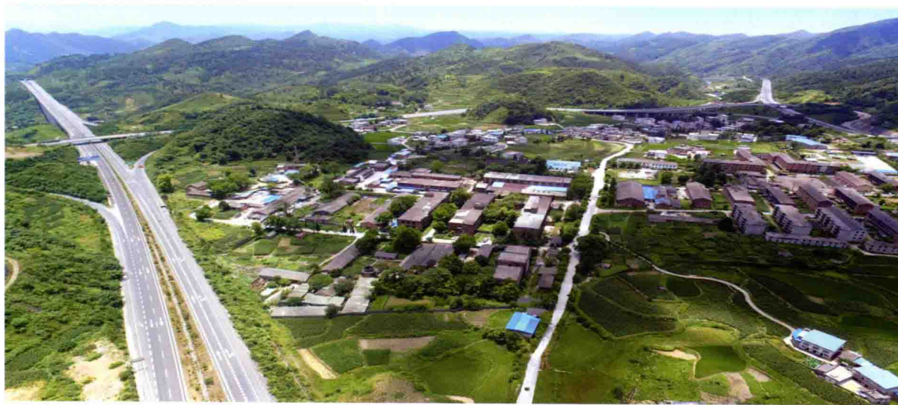
厦蓉高速公路与兰海高速公路都匀互通工程
