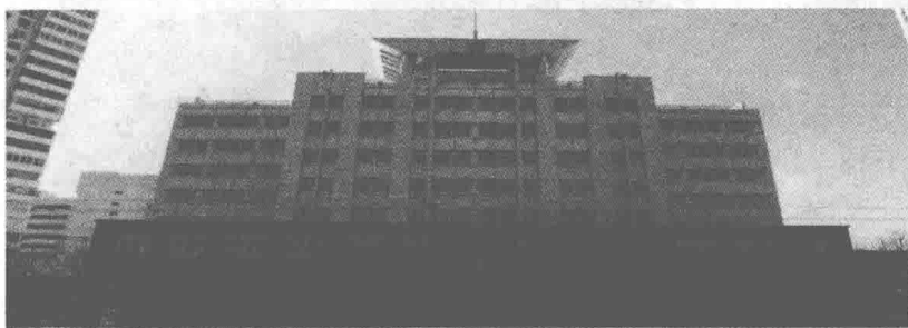
图1.1 中国科技部建筑节能示范楼
