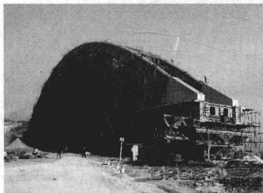
图 1-3 支架施工法施工
