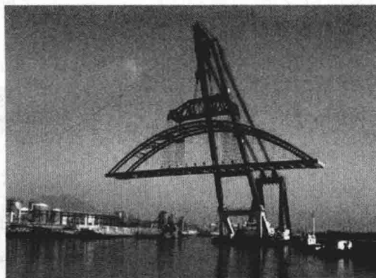
图 1-4 整体吊装法施工
