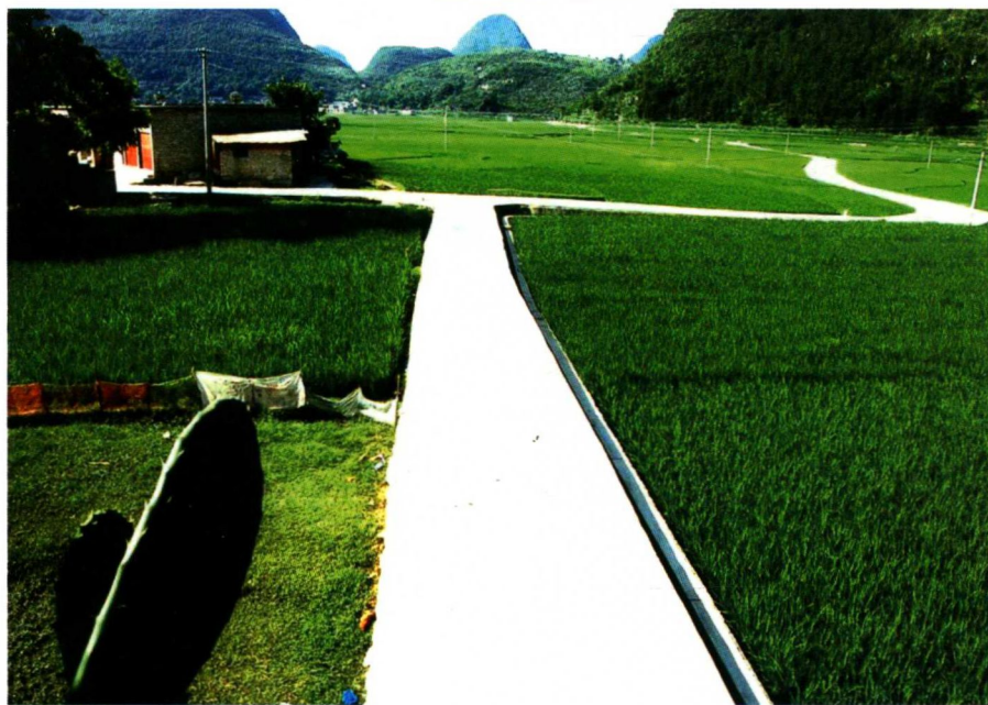
1999年，镇宁县整村推进项 目完工，村寨道路修葺一新
