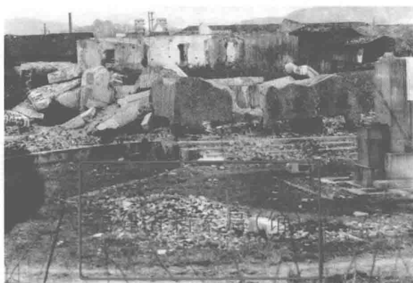
抗战爆发后，医院大部分设备、人员迁往闽北山区，福州院址在日机轰炸中化为废墟。图为福建省立医院门诊部、办公室被炸后的情形
