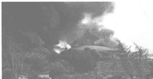
图1-5 2011年8月29日10时06分,中石油大连石化分公司七厂柴油储油罐发生火灾。现场知情人员称,这次火灾是由于工作人员操作过程中发生静电起火引发爆炸而引起的
