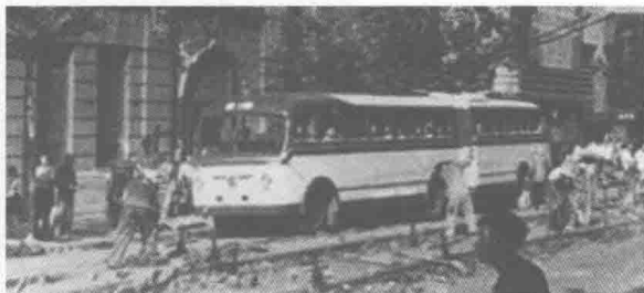
图 1-4 上海有轨电车拆除
