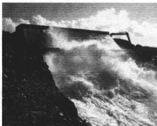
图 1.4.5 岸式摆式装置工作图
