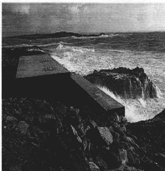
图 1.2.1 Limpet 振荡水柱式波能发电装置
