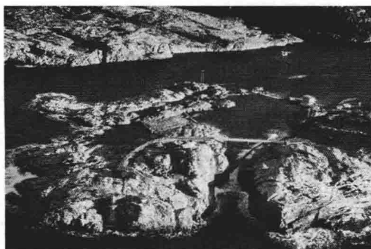
图 1.4.9 挪威 350kW 聚波围堰电站
