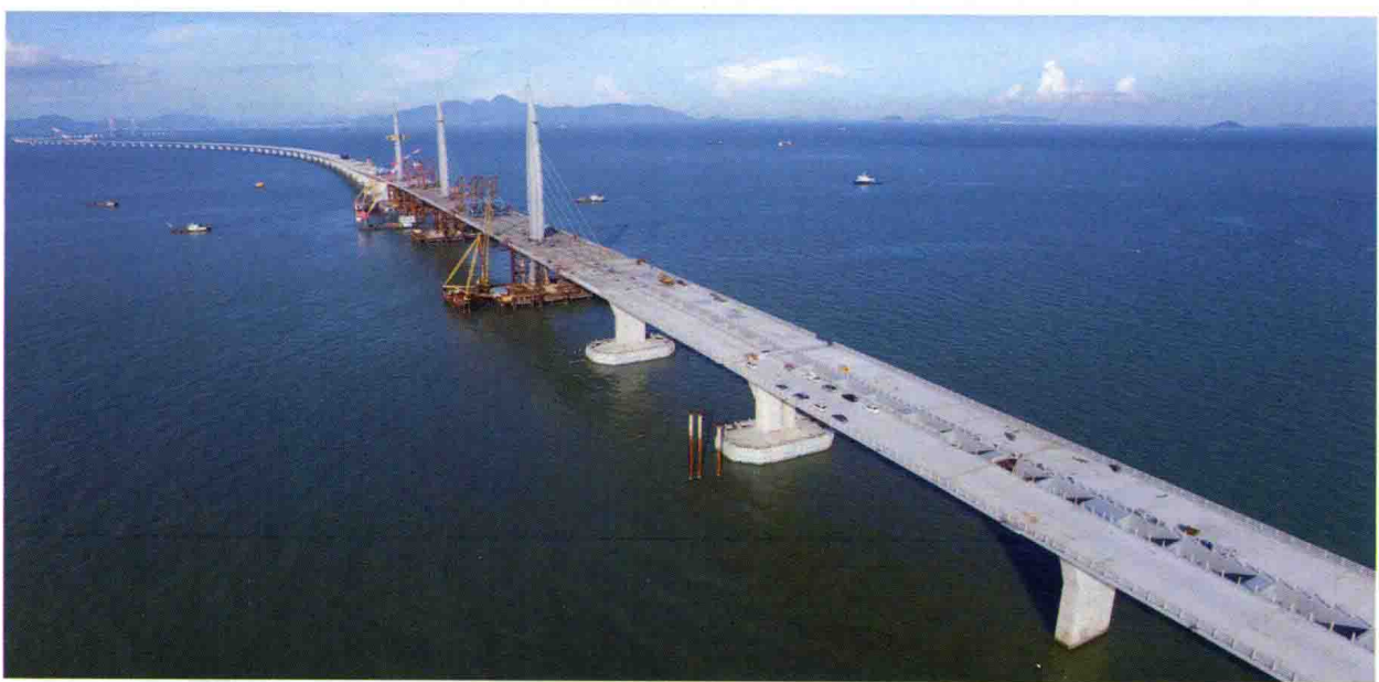
通航孔桥钢箱梁安装
