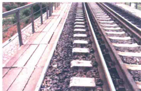
图 1-1-8 桥上挡砟板
