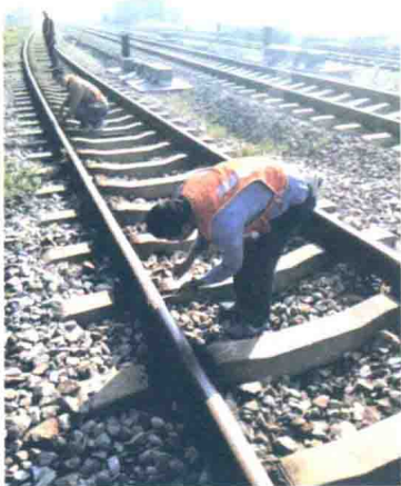
图 3-19-3 检查岔后连接曲线正矢
