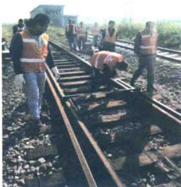
图 3-19-2 轨距、水平的检查
