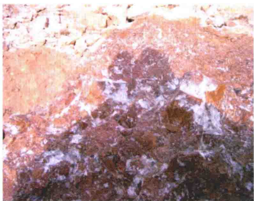
图 1-3 洞口段饱冰冻土地层
