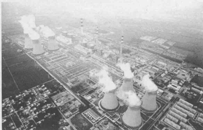
图 1-20 火力发电厂实物图
