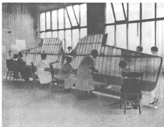
图 1-2 早期美国飞机工业采用 油布制作蒙皮 (网络图片)
