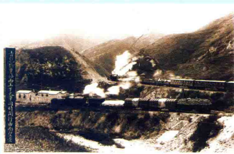
▲ 作为京张铁路的总工程师，詹天佑创造性地运用了“人字型”铁路，使火车能在山区陡坡通行。
