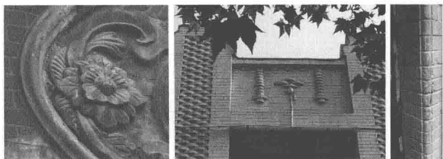
图 18 带有细致艺术雕刻的砖，以及建筑转角处的异形砖搭配
