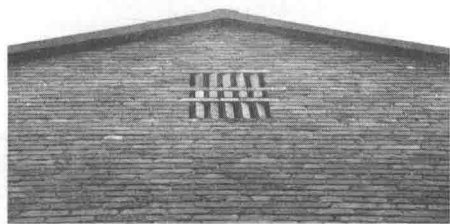
图8 德租界海寿里的一处建筑立面,青砖墙是美式砌筑
