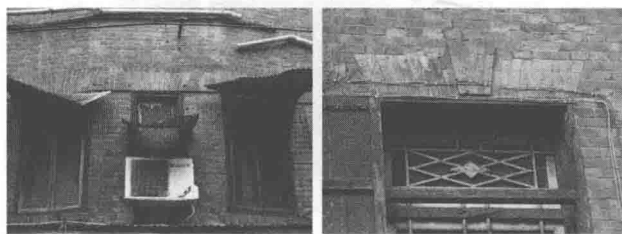
图10 老汉口俄租界珞珈山路红砖建筑窗户上的平券
