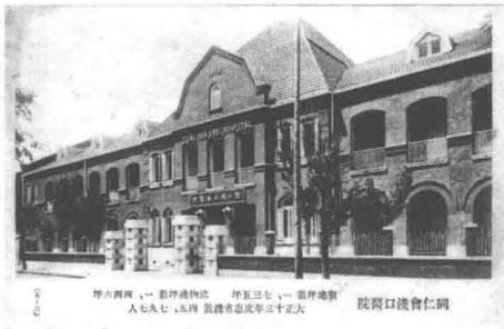
图6 同仁会汉口医院建筑全部由清水砖构造，一、二层外廊拱券砖砌筑变化特征明显
