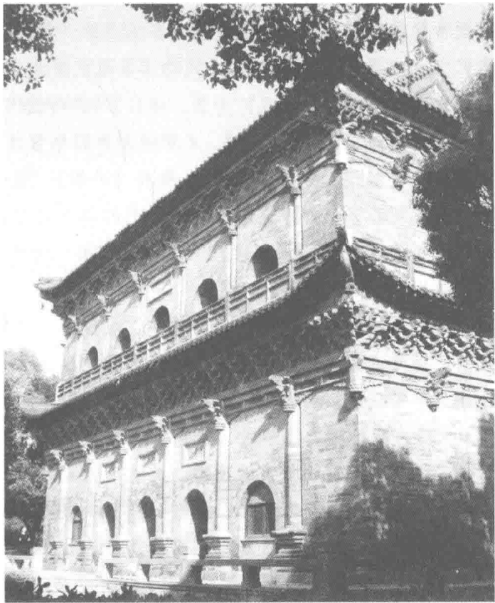
图 0-2 苏州开元寺砖造无梁殿
