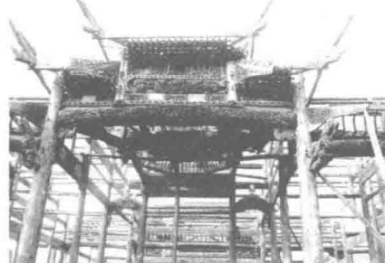
五凤楼梁架施工中
