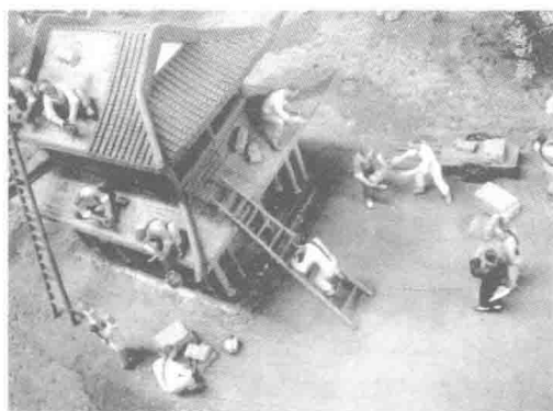
歇山回顶屋面铺就椽，望后，抹护望灰，开线垄瓦作檐头
