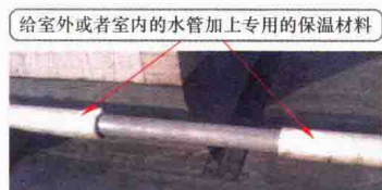
图 1-5 水管保温措施
