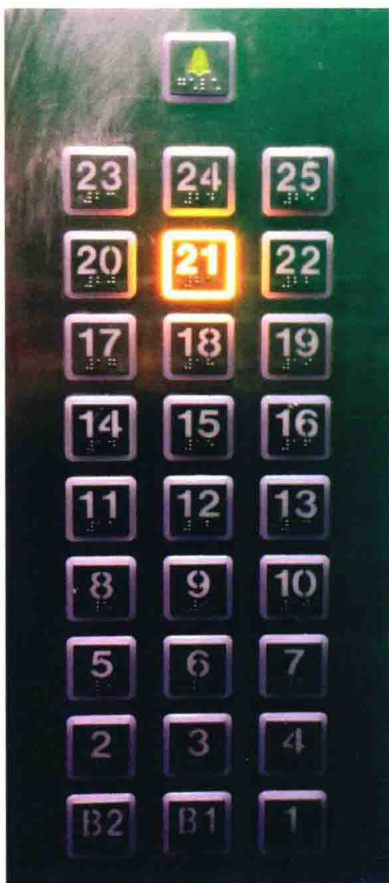
图1-4 无语音提示的电梯的轿厢操作面板
