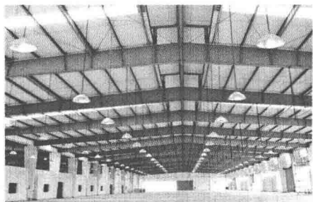
图1-18 轻型钢结构厂房
