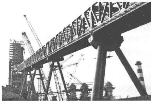
图1-17 宝钢一号高炉上料系统主皮带通廊
