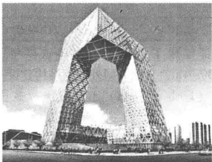
图 1-3 中央电视台总部大楼
