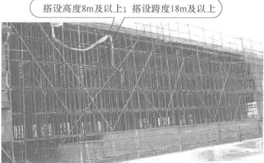
图 1.1-16 搭设高度 8m 及以上、搭设跨度 18m 及以上高支模搭设实例
