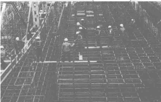
图 1.1-21 高大模板脚手架搭设
