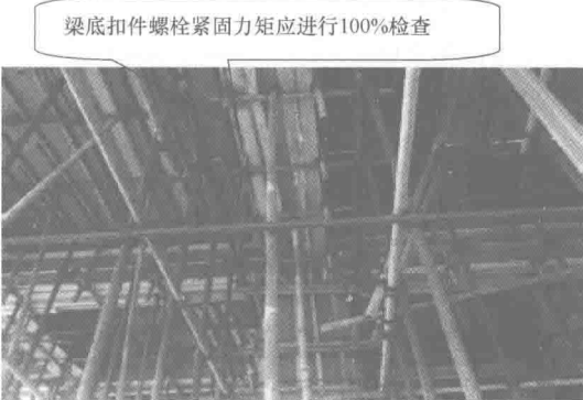
图 1.1-19 螺栓紧固力矩检查
