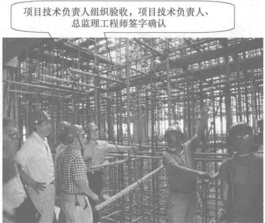
图 1.1-18 高支模脚手架验收
