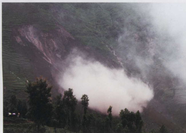
2010年6月28日，关岭县岗乌镇降特大暴雨，造成大寨村山体滑坡。图为抢拍到的山体滑坡时照片
