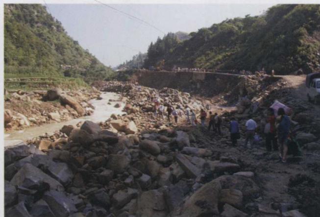
2009年7月27-28日,位于望谟县城上游的打易镇降水量186.3毫米,洪水顺流而下冲毁打易镇至望谟县城的209省道
