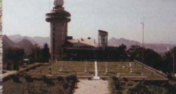
贵阳多普勒天气雷达站 2001.9
