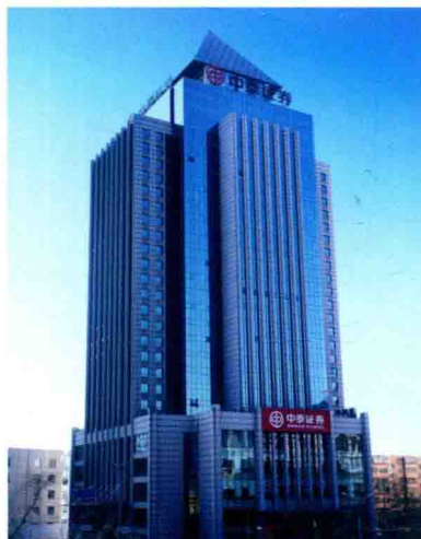
中泰证券总部大楼
