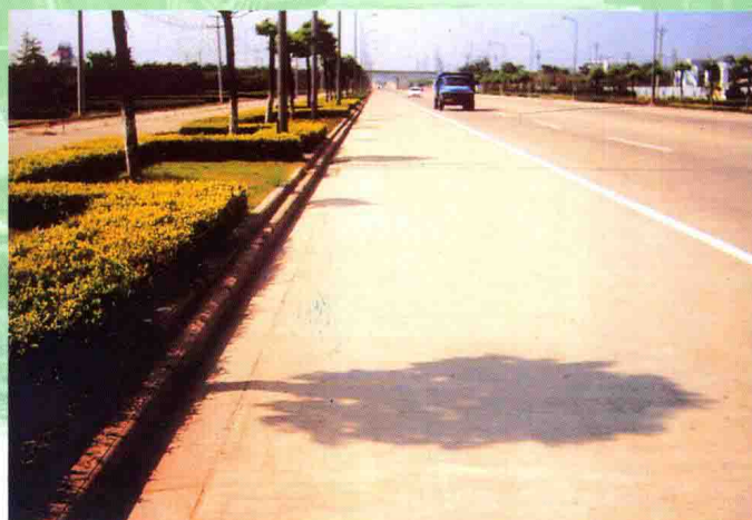
东湖环湖路污水处理工程
