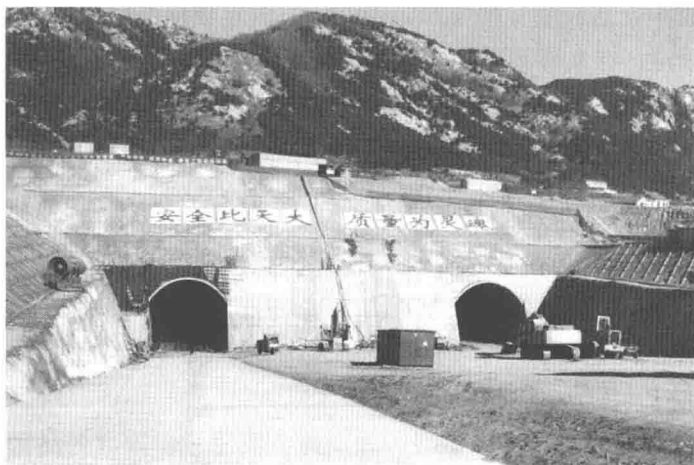
图1.5 国家石油储备某洞库施工巷道入口
