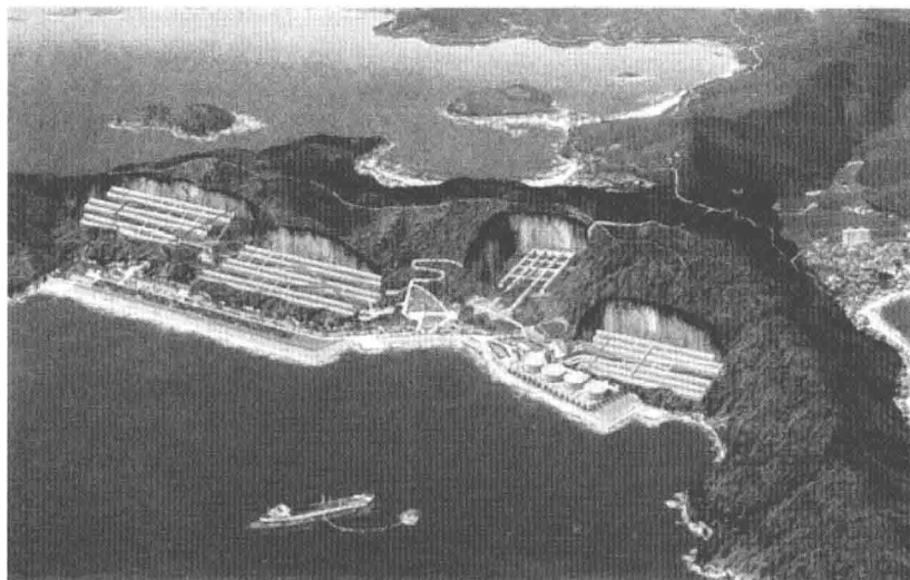
图1.2 韩国丽水地下水封石洞原油库
