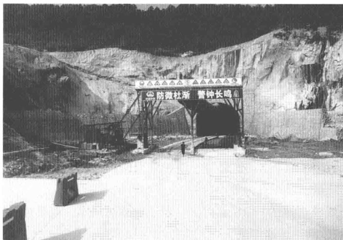
图1.7 第三某地下水封石洞油库入口
