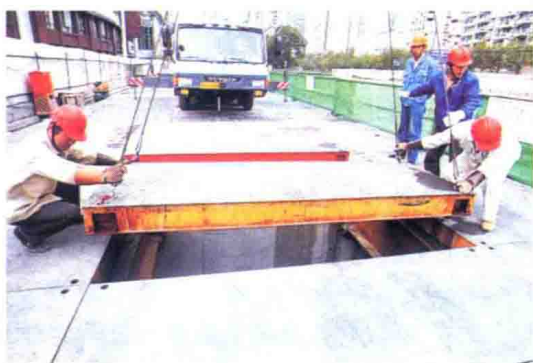
图 2-4 地铁站盖挖法施工现场
