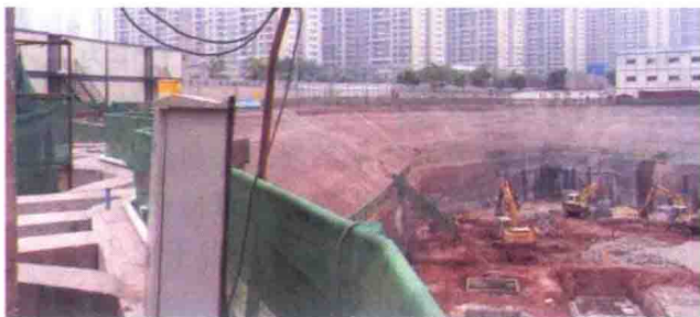
图 2-5 基坑边坡放坡处理
