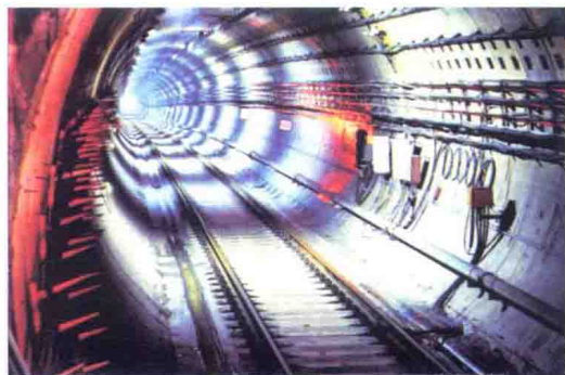
图 2-2 地铁区间隧道
