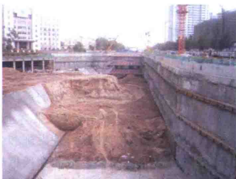
图 2-3 明挖法施工现场
