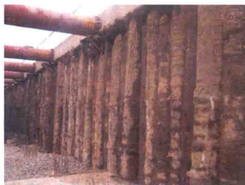
图 2-7 水泥土挡土墙支护结构
