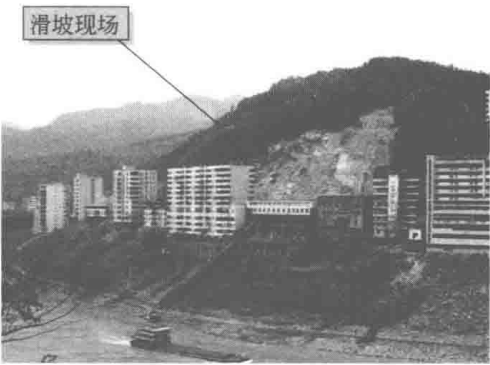
图 1.2 重庆武隆滑坡 Fig 1.2 Landslide in Chongqing Wulong
