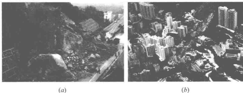
图 1.1 边坡的垮塌事故
