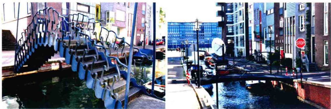
跨越河道的钢构波纹小桥
