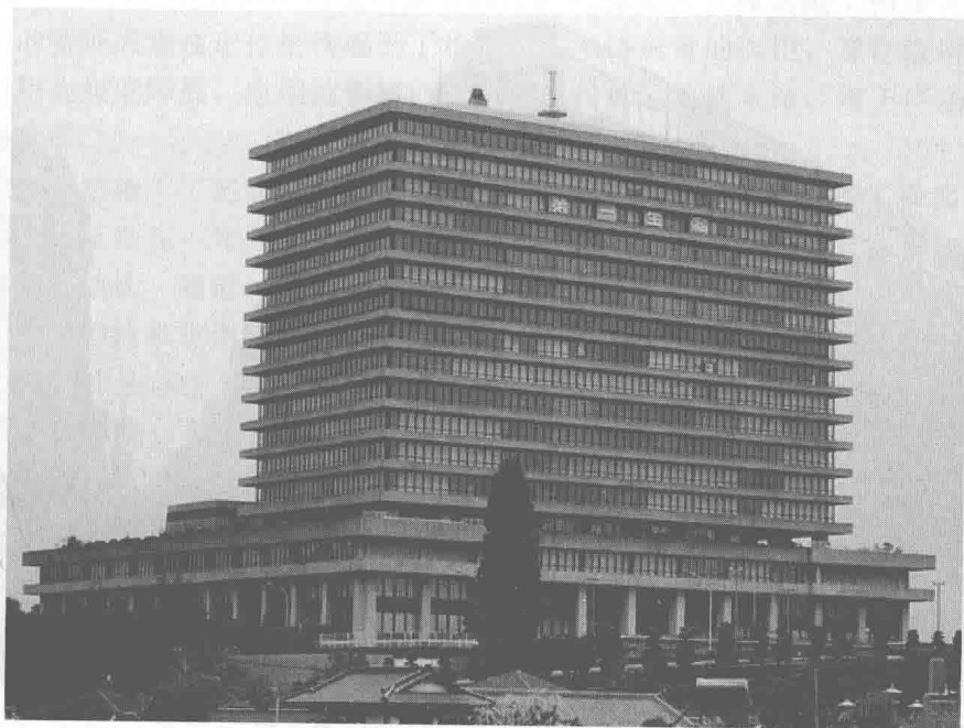
图 1.2-1 第一生命保险株式会社本社大厦
