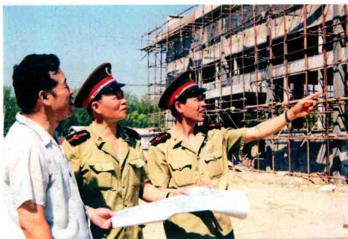
1990年夏，大兴县人民武装部领导在基地教学大楼施工工地
