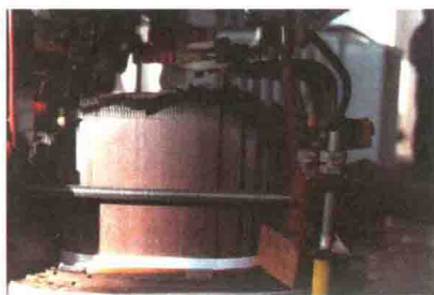
图 3 变压器铁芯硅钢片错位
