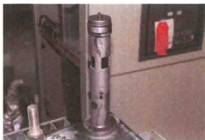
图 1 压力释放阀喷油痕迹
