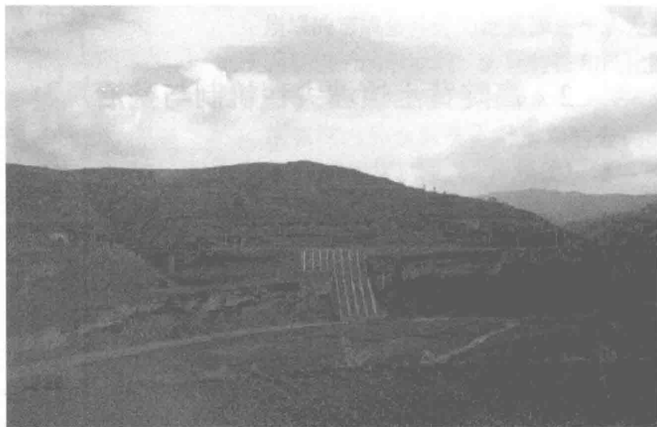
图 2-1 宝中线 K154+200 高路堤滑坡位置全景
