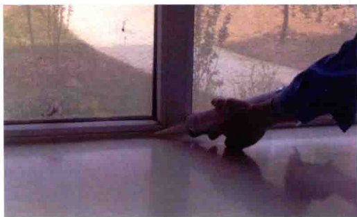
安装完成后的人造石需要打胶填缝。
