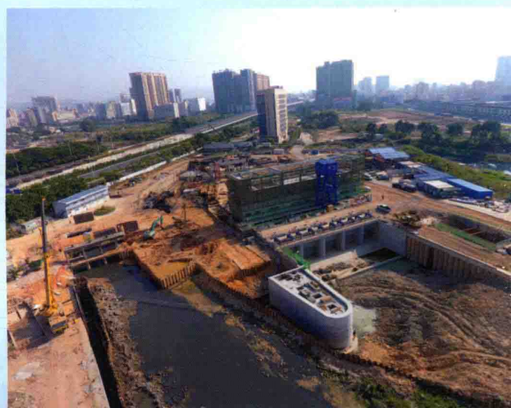
深圳市茅洲河综合整治项目上寮河口泵站工程
