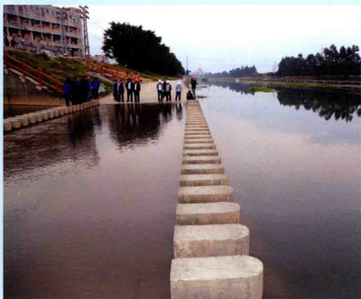
整治后的深圳市茅洲河宝安区罗田水汇入段
