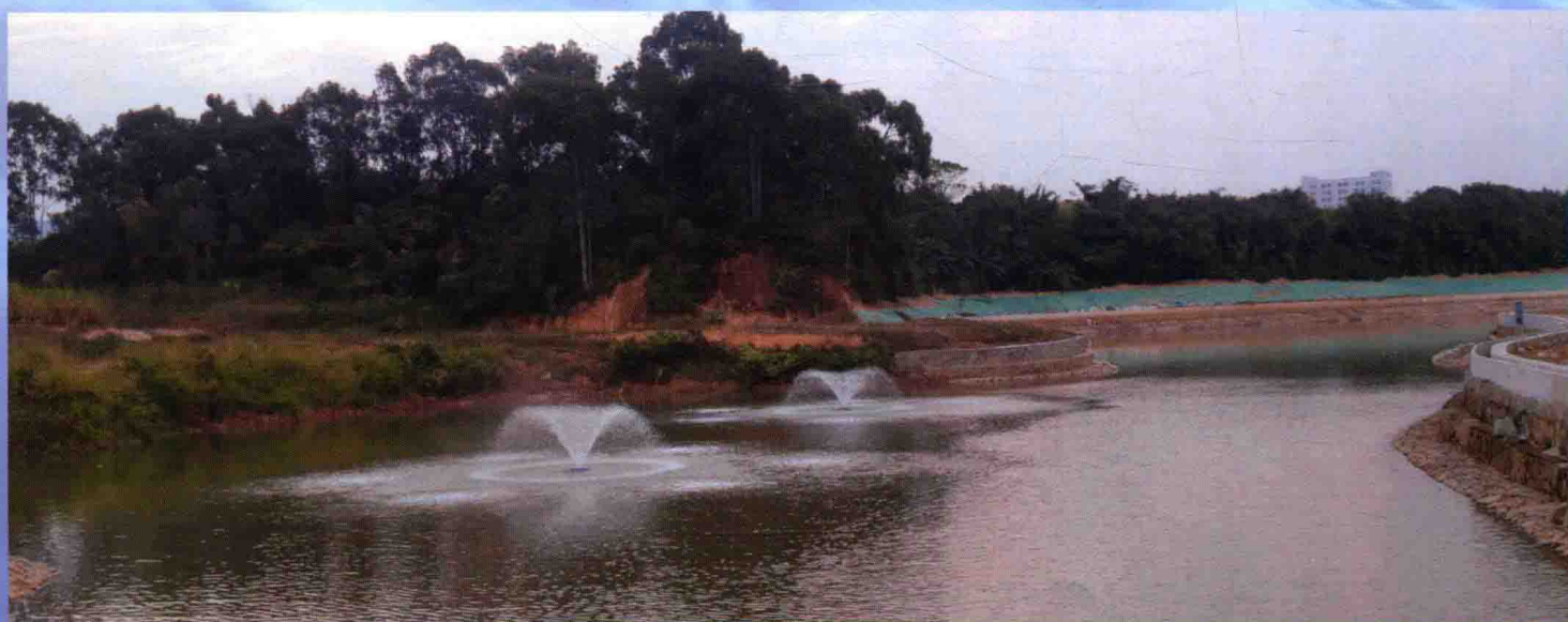
深圳市宝安区罗田水调蓄湖工程
