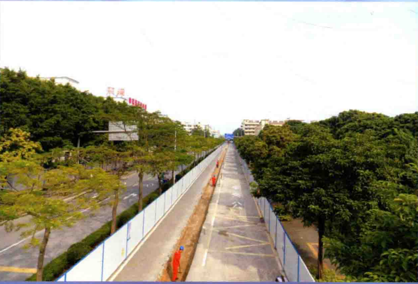
深圳市宝安区松岗水质净化厂雄宇路路面恢复工程
