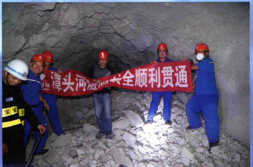
深圳市茅洲河综合整治项目潭头河隧道顺利贯通
