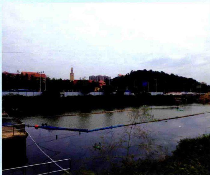
整治后的深圳市茅洲河龟岭东水段
