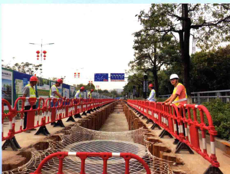
深圳市茅洲河综合整治项目临边防护工程
