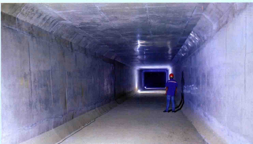
深圳市茅洲河综合整治项目楼岗河分流箱涵工程
