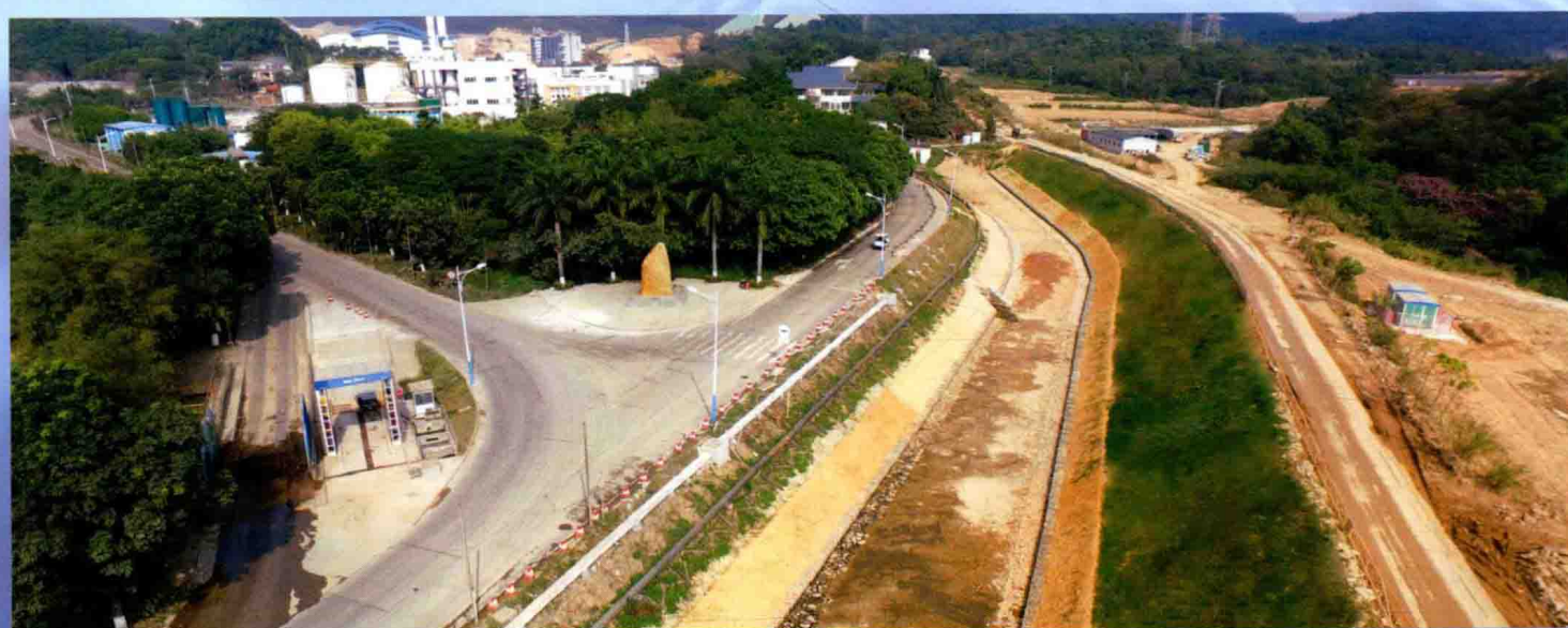
深圳市茅洲河综合整治项目老虎坑水B支流石笼护坡、护底与绿化工程
