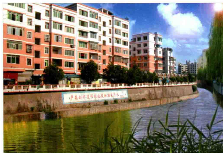
治理后的县城河道(2004年)
