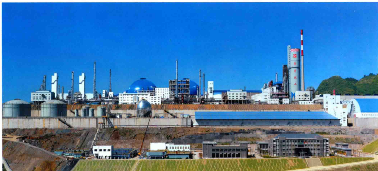
竣工投产的桐梓煤化工项目工程（2011年）
