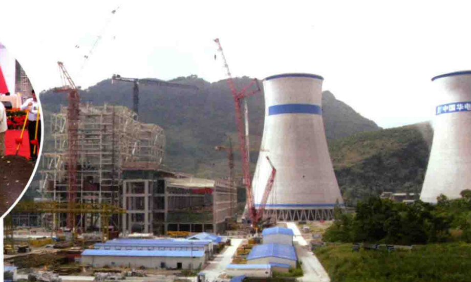
建设中的桐梓电厂（2012年）
