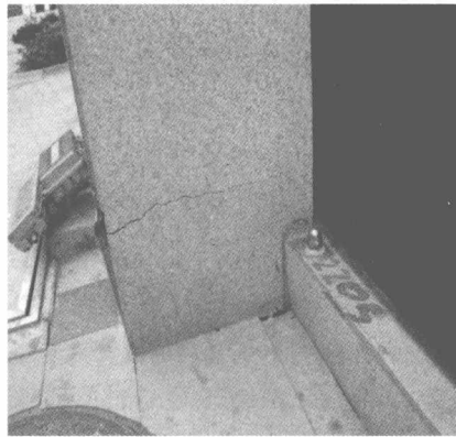
图 4 建筑物裂缝
