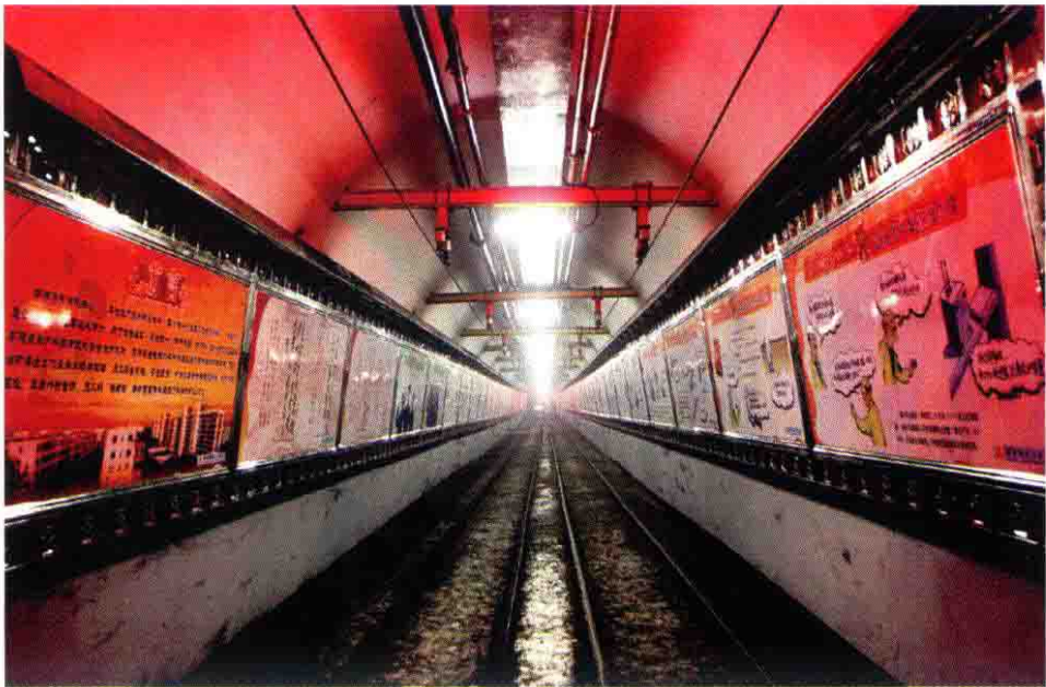
至“十一五”时期，山西煤矿井下布置已实现现代化。图为潞安矿业集团矿井现代化运输巷道
