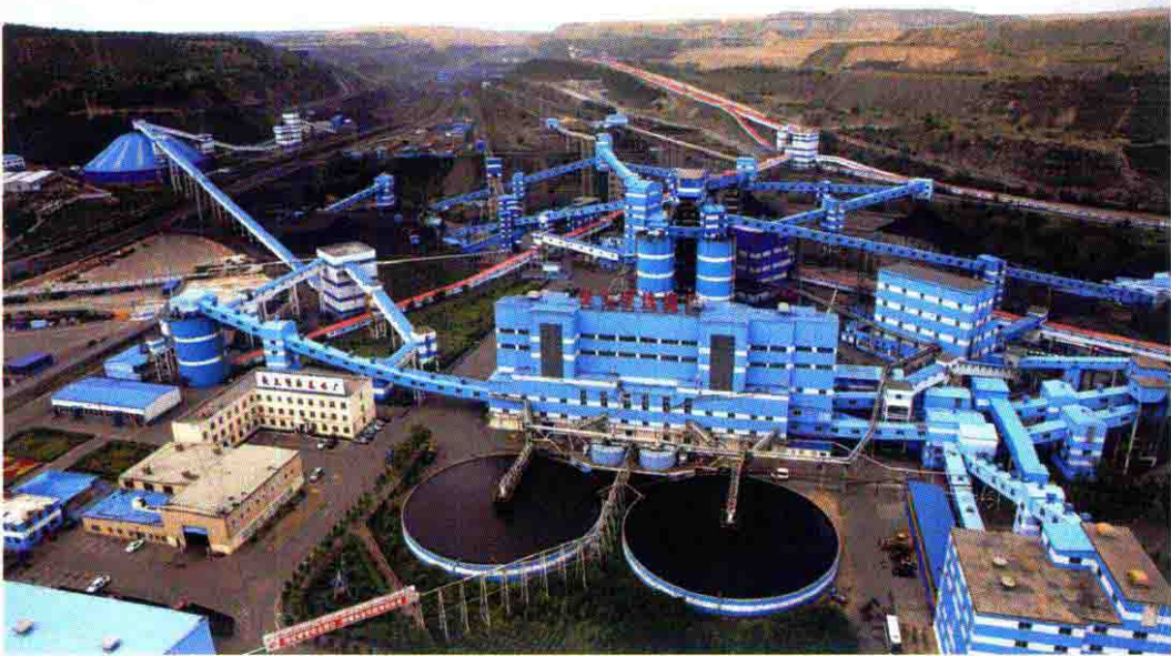
经过“八五”时期至“十一五”时期的建设，平朔露天煤矿已建成世界最大的露天矿区。图为安太堡露天煤矿
