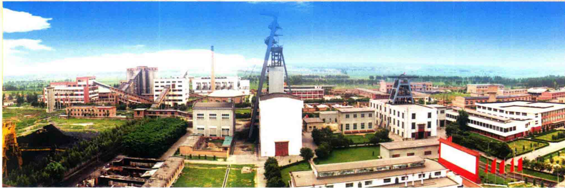
“八五”时期建成的全国煤炭系统第一个世界银行贷款项目潞安矿业集团常村煤矿（设计能力为 400 万吨 / 年）
