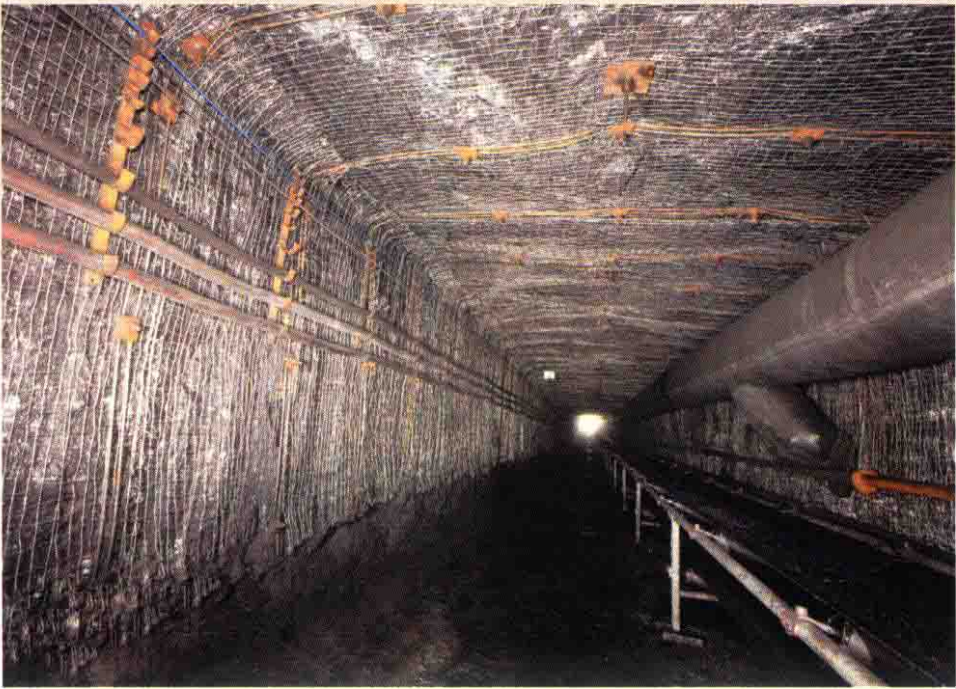
至“十一五”时期，山西大中型矿井支护技术日趋先进。图为三元煤业公司矿井巷道锚网支护
