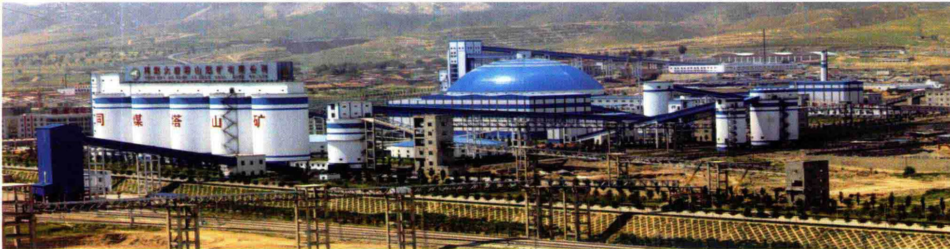
“十一五”时期建成的以年产 1500 万吨矿井为龙头的大同煤矿集团塔山循环经济工业园区一角
