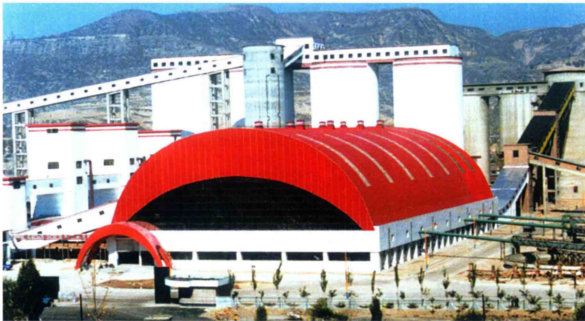
由太原煤矿设计研究院设计、于“十五”时期建成的西山煤电集团古交矿区屯兰选煤厂
