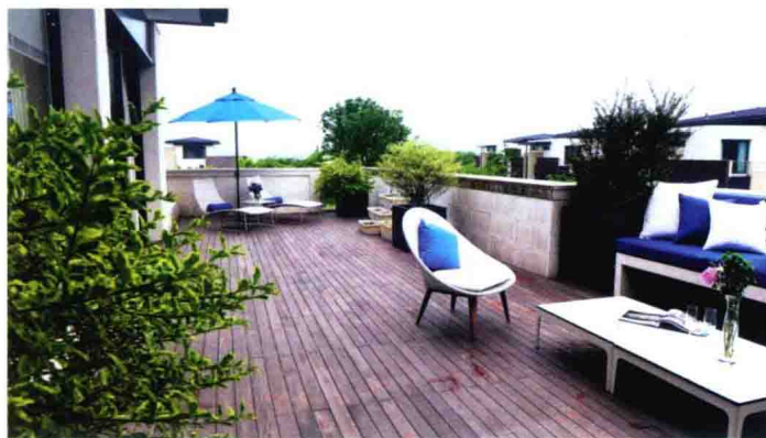
▲ 露台花园铺装全部采用防腐木，运用内嵌式卡洞，钉不外露，美观干净。
