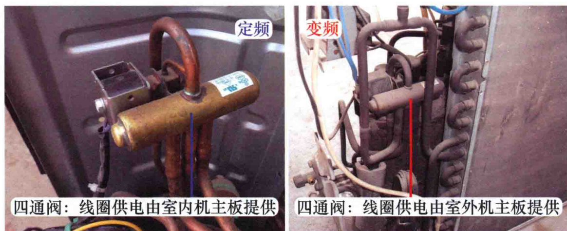
图 1-12 室外机制冷/制热转换器件对比
