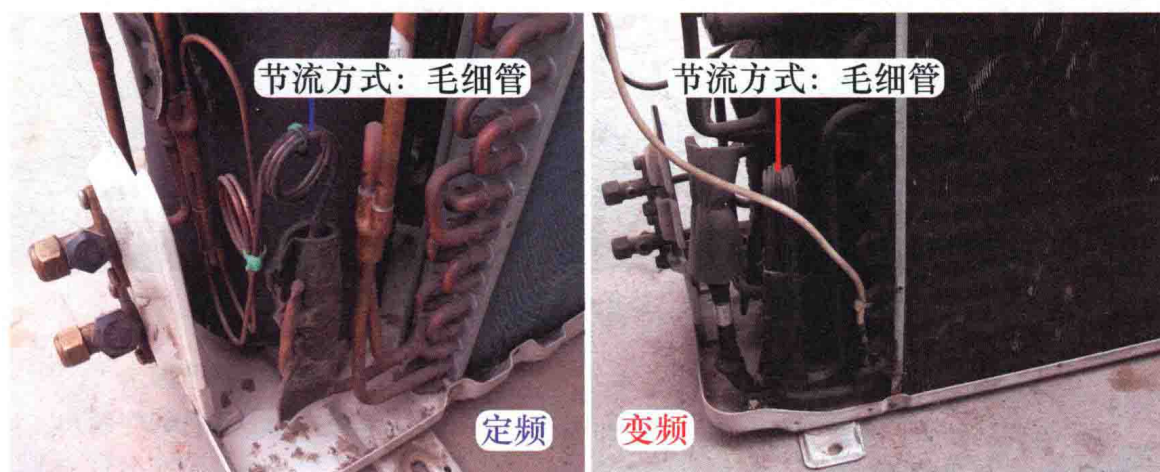
图 1-10 室外机节流方式对比
