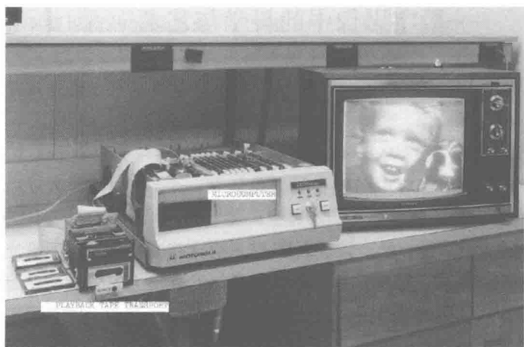
图 0-2 柯达样机的播放系统与它所拍摄的全球第一张数字照片
