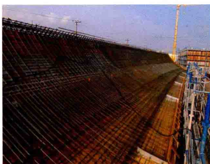
钢筋混凝土结构的屋檐的施工景象。山墙面设有裂纹检测板, 确定需维护位置
