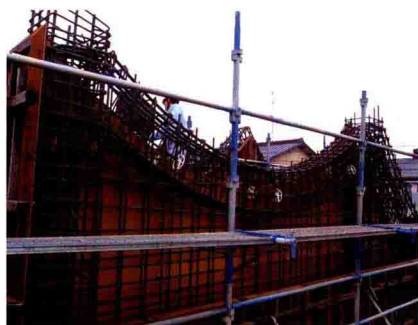
屋檐梁的配筋 (钢筋布置)
