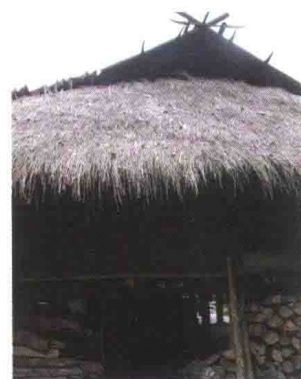
图10 临沧佤族翁丁民居的茅草屋顶以及被遮盖的木制墙体，底层为堆放杂物的空间
