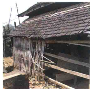
图9 章朗村布朗族民居的围护墙体用竹篾、木等材料
