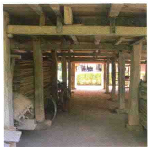
图8 傣族勐景来村民居的地基，其上架柱子，柱子与地基之间垫以石块
