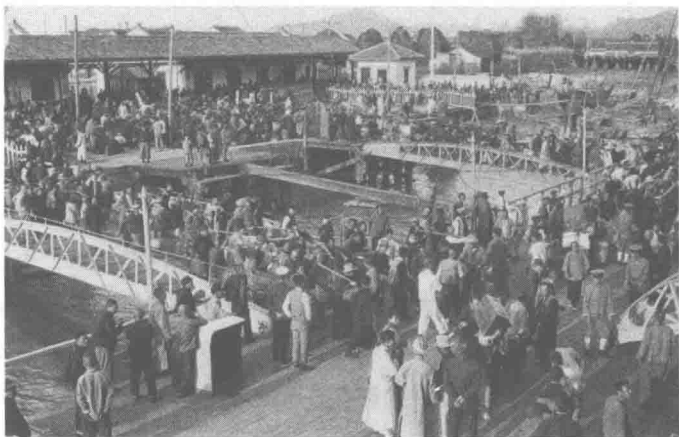
▲ 上海外白渡桥港口
