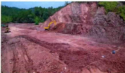
放线确定开挖轮廓线
