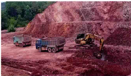
土方分层开挖
