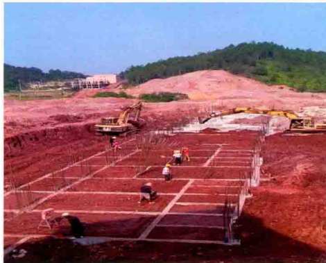
基础土方回填
