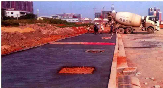
砂垫层施工
