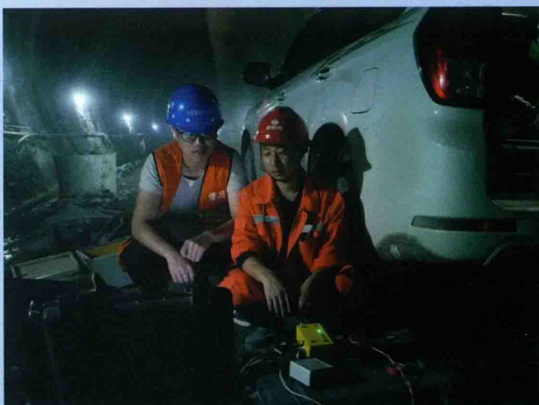
输水隧洞超前预报 TSP 现场测试
