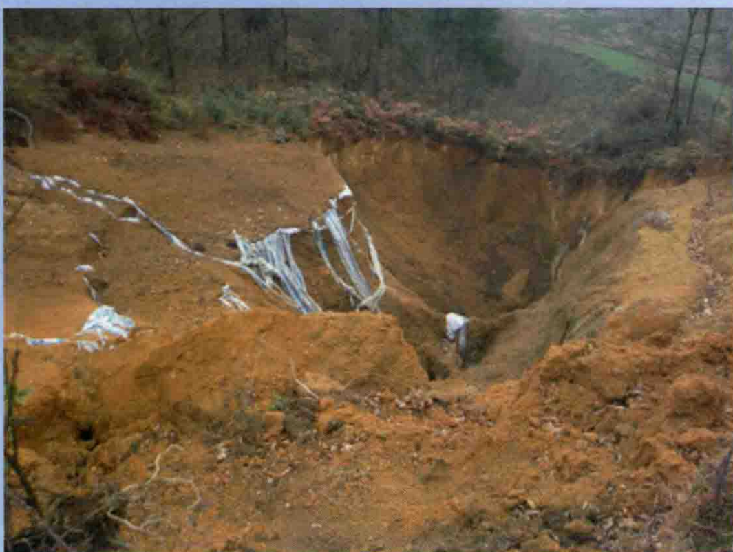
隧洞超前预报地表调查（地表塌陷）
