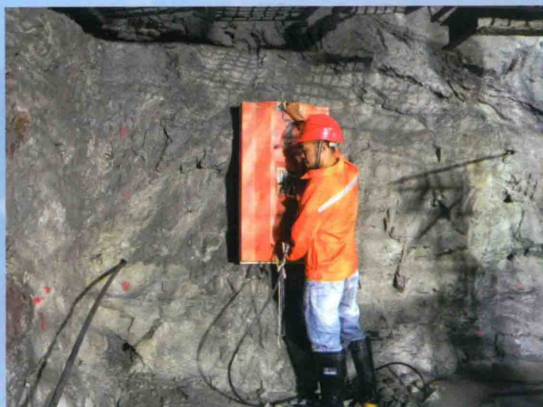
输水隧洞超前预报地质雷达现场测试
