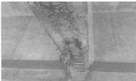
图 1-22 钢筋锈蚀
