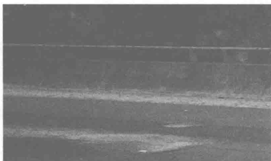
图 1-2 面层脱落
