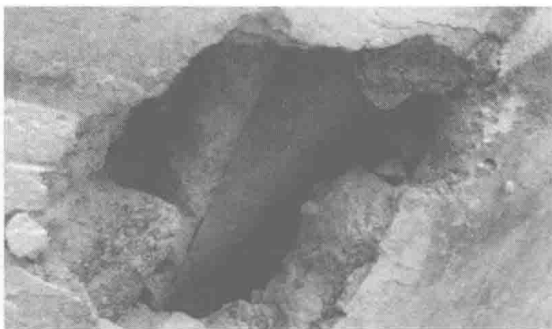
图 1-18 混凝土空洞
