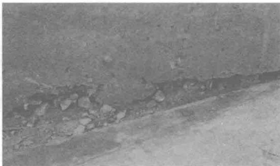
图 1-20 混凝土剥落
