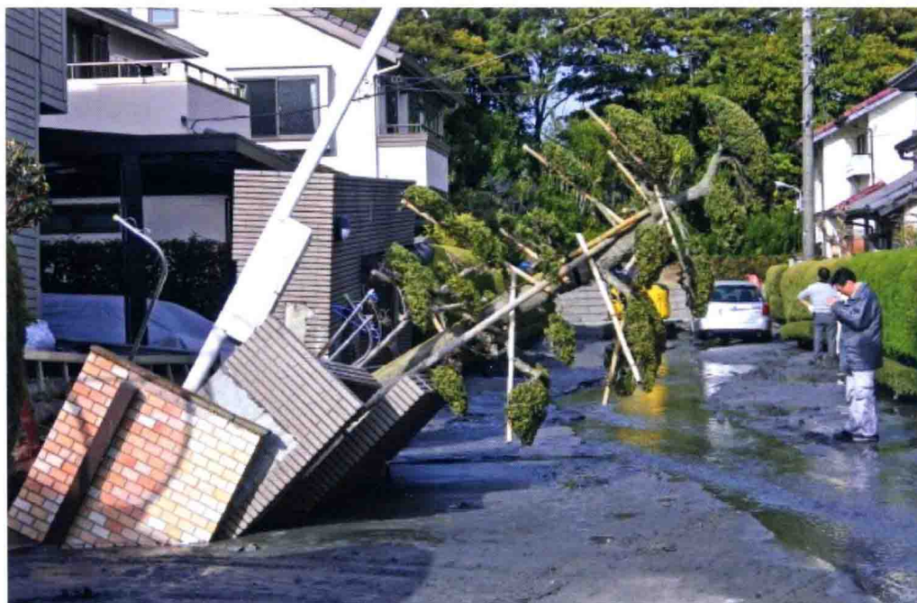
图 1-4-2 液化导致地面破坏
