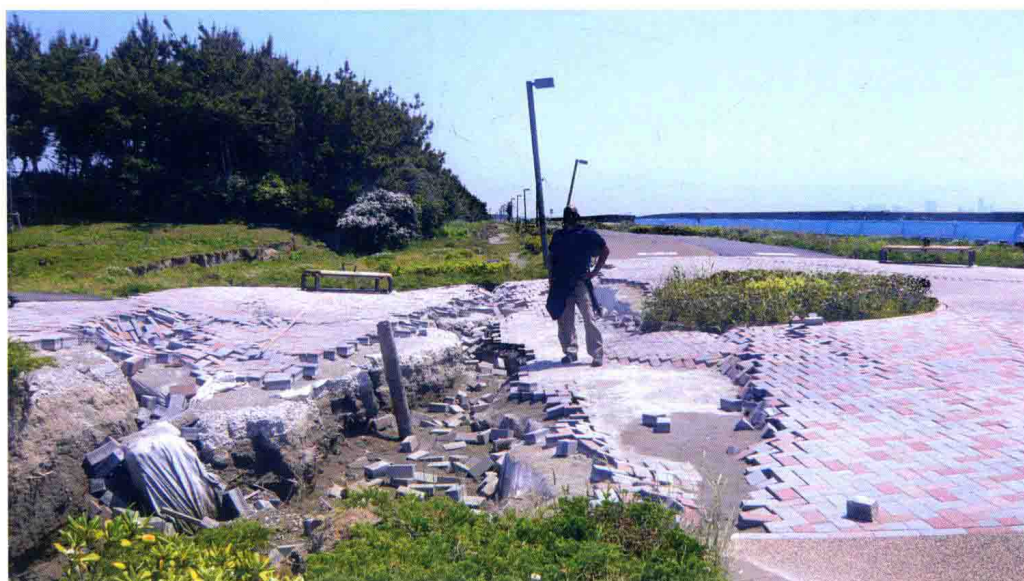
图 1-4-1 海堤的内陆地沉陷
